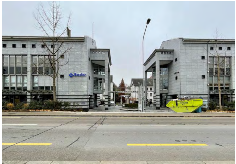
Abbildung 3 Foto Bestand, Ansicht von "Schaffhauserstrasse"
