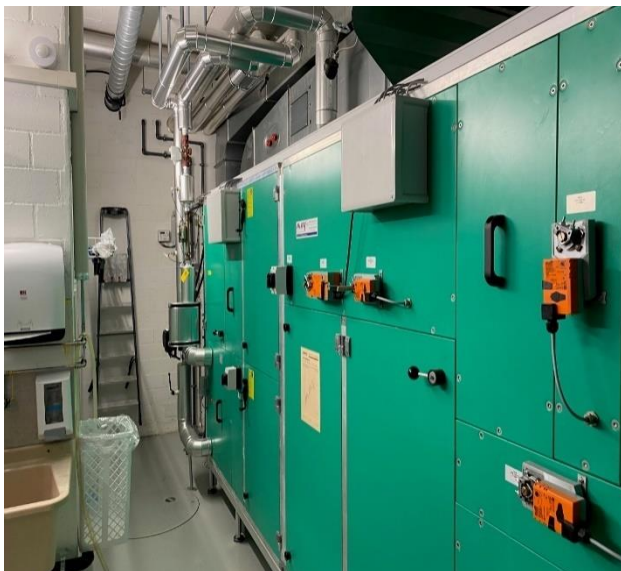
Sanierte Lüftungsanlage
