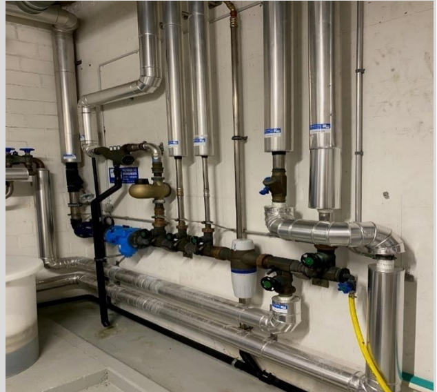
Teilersatz Wasserverteilung
