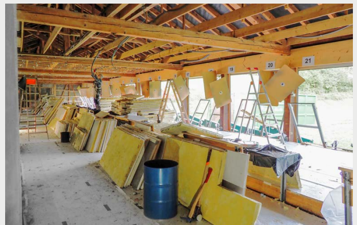
27 Sanierungsarbeiten für die Schallschutz-Isolation
