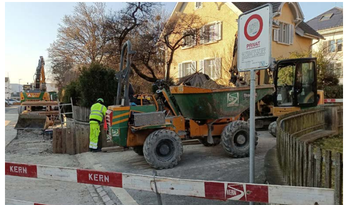
57 Sanierung der Entwässerung am Grampenweg
