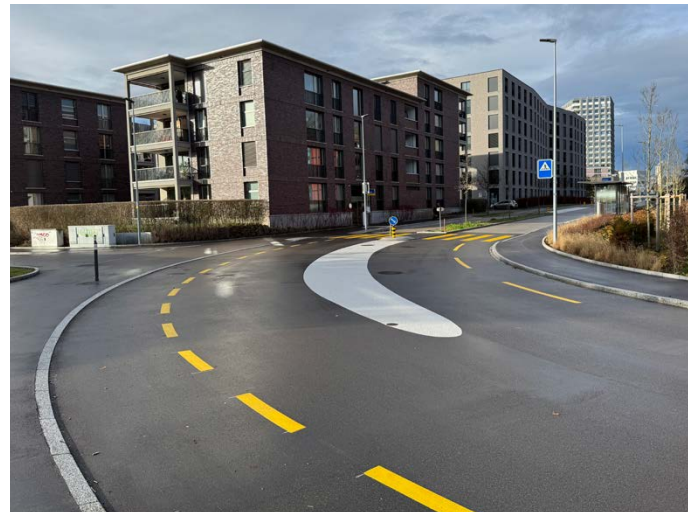
59 Fertig gestelltes Projekt Solistrasse, Fangleten- bis Soligänterstrasse, Blickrichtung Fangletenstrasse
