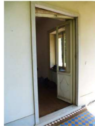
Fig.2 Immagine prima del montaggio del ventilatore sulla portafinestra – Esterno
