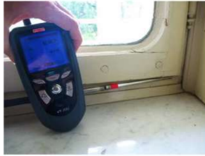
N.5 Perdita telaio apribile in corrispondenza del traverso inferiore – Valore perdita: 2,97 m/s
