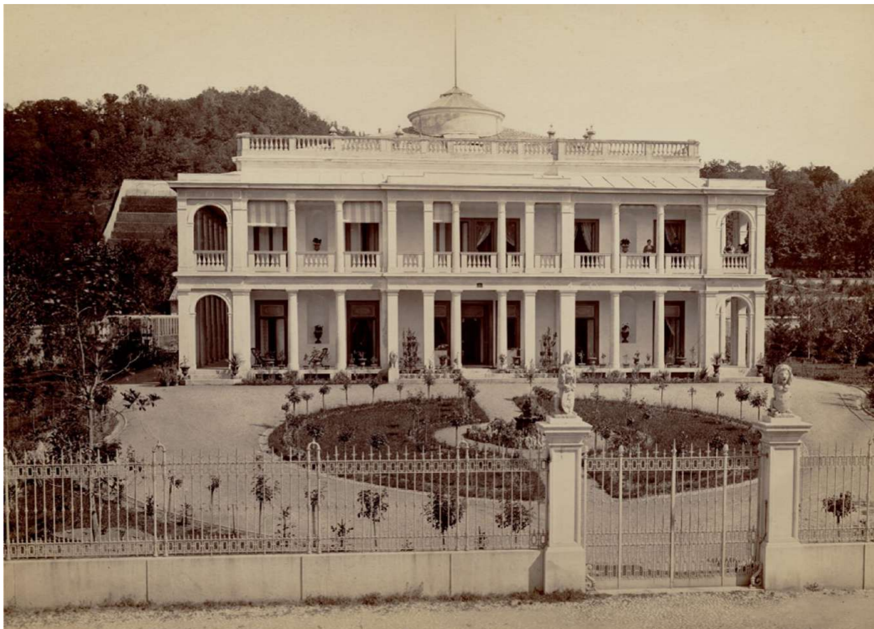
Vista del fronte principale, 1900 ca., Archivio Gino Macconi.
