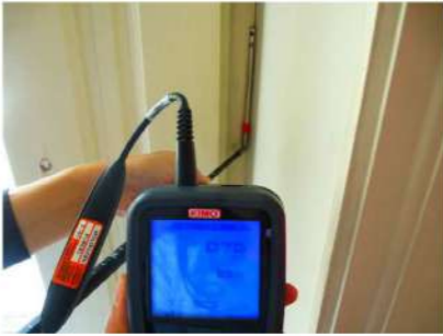
N.7 Perdita telaio apribile in corrispondenza della cerniera superiore – Lato dx – Valore perdita: 0,75 m/s
