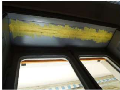
Immagine 1 – sigillatura temporanea tramite nastro del vano alloggio tenda a rullo
