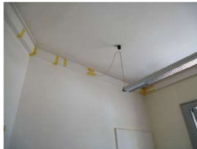
Fig.5 Sigillatura della canalina porta impianto elettrico in corrispondenza delle giunzioni di ogni coperchio di chiusura
