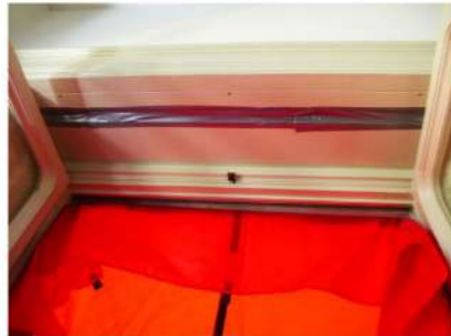
Immagine 3 – sigillatura temporanea tramite nastro del vano alloggio tenda a rullo
