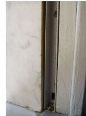
Immagine 5 – Guida tapparella esistente non a tenuta
