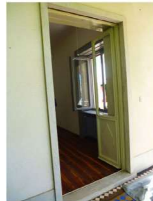
Fig.2 Immagine prima del montaggio del ventilatore sulla portafinestra – Esterno
