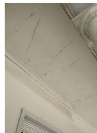
Immagine 1 – intradosso solaio esterno
