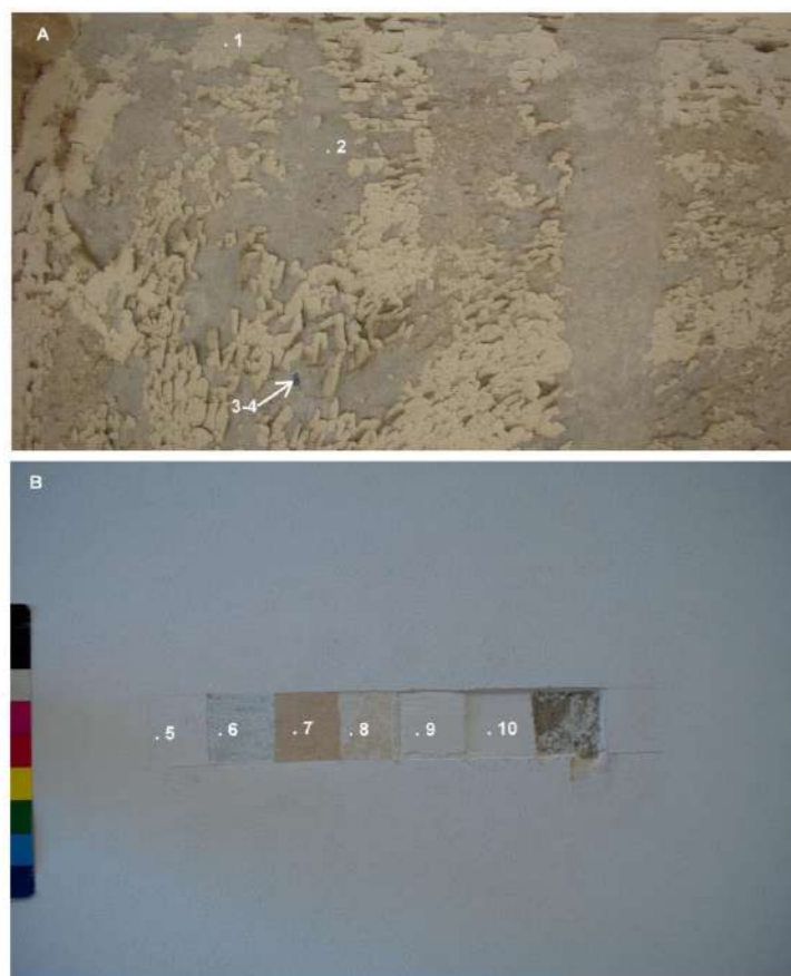
Figura 7. Punti di misura dell'analisi HH-XRF. A) Prospetto Est, lato interno al loggiato, prima arcata da Sud B) Stanza V106, parete Sud.
