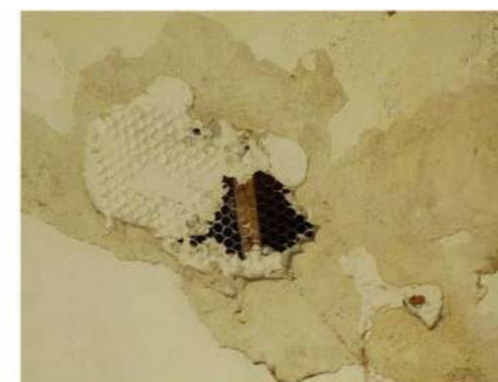
Immagine 3 – intradosso solaio esterno
