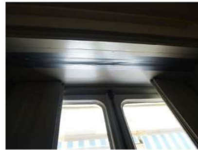
Immagine 2 – sigillatura temporanea tramite nastro del vano alloggio tenda a rullo
