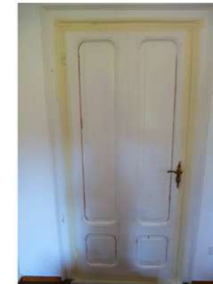
Fig.1 Sigillatura della porta interna di collegamento con la stanza adiacente
