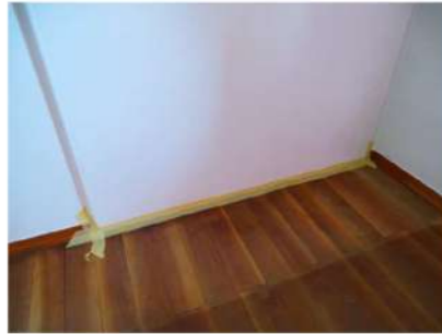
Fig.3 Sigillatura del raccordo tra il profilo inferiore della controparete in cartongesso e il pavimento
