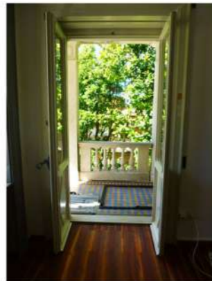
Fig.1 Immagine prima del montaggio del ventilatore sulla portafinestra – Interno
