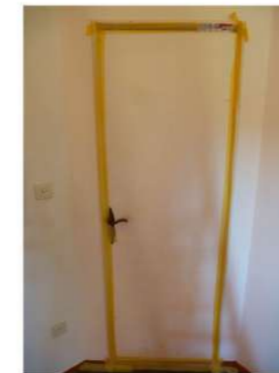
Fig.2 Sigillatura della porta interna di accesso alla stanza
