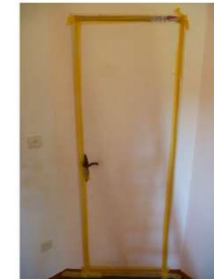
Fig.2 Sigillatura della porta interna di accesso alla stanza
