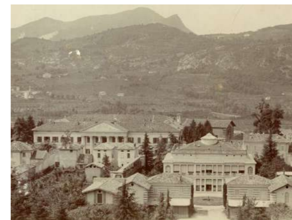
Vista della Villa e del parco del berceau, Archivio Gino Macconi
