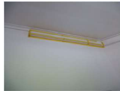
Fig.4 Sigillatura della canalina porta impianto elettrico in corrispondenza delle giunzioni di ogni coperchio di chiusura
