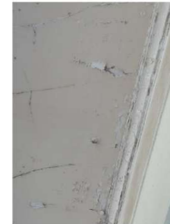
Immagine 2 – intradosso solaio esterno
