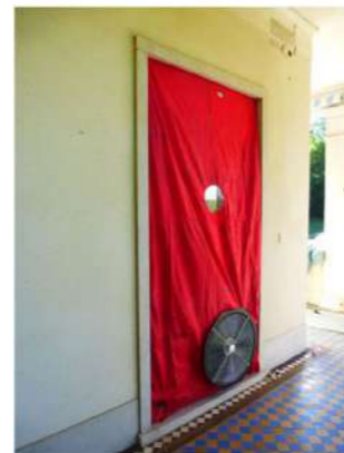
Fig.4 Immagine dopo il montaggio del ventilatore sulla portafinestra – Esterno
