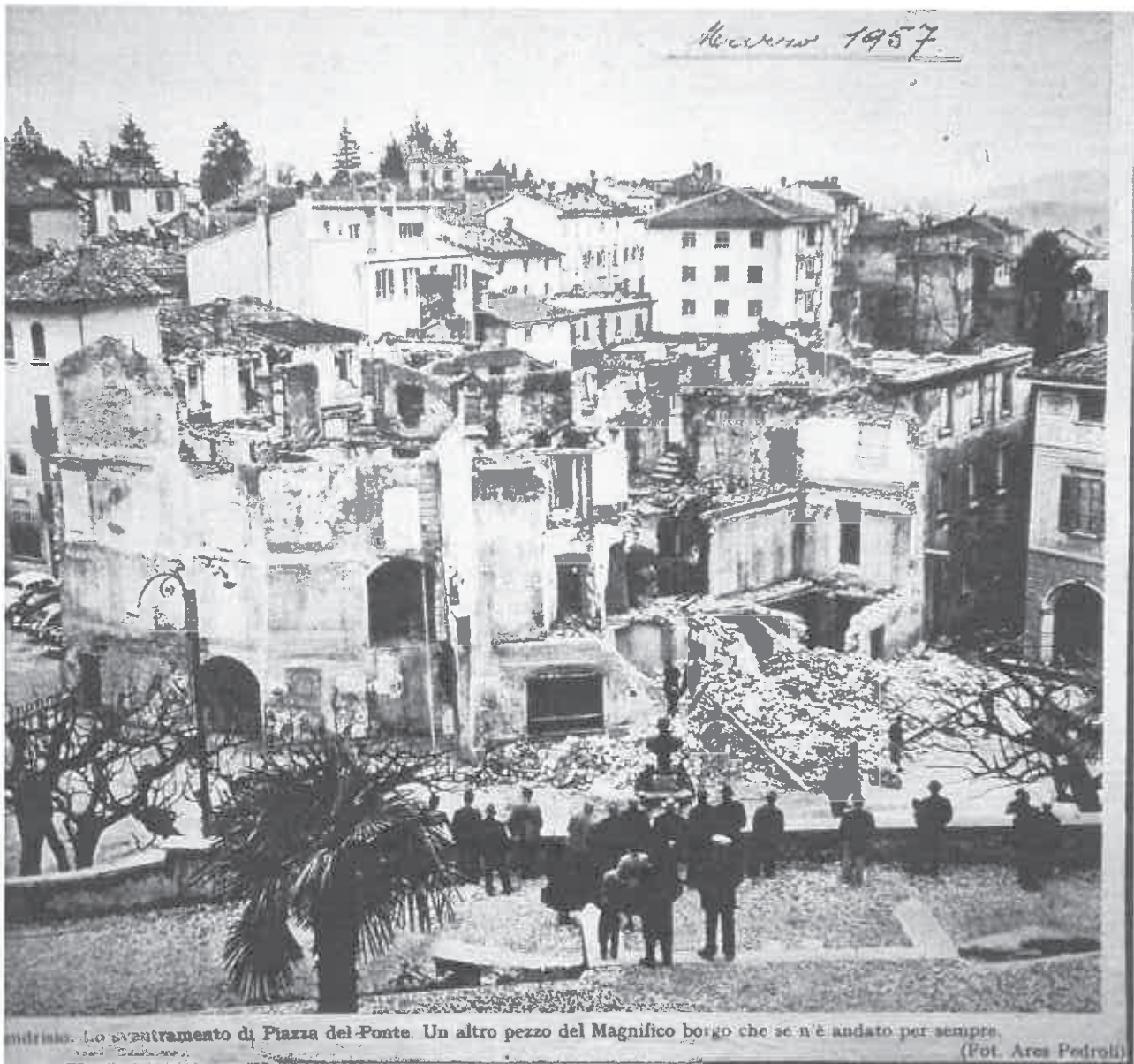
Sventramento del nucleo storico: demolizione del caseggiato Pasta, marzo 1957
