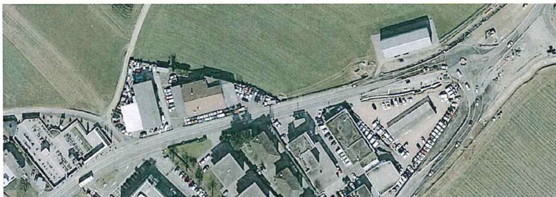
Il tratto ciclabile tra la rotonda Croce Grande (nella foto in costruzione) e il cimitero rimane problematico e dovrà essere oggetto di studio in caso di progettazione.
