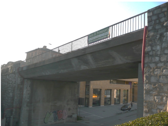
Foto piattabanda e spalla sud
