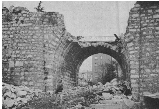
Lavori di demolizione del ponte ad arco, 1970
