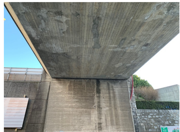
Foto intradosso piattabanda e spalla nord
