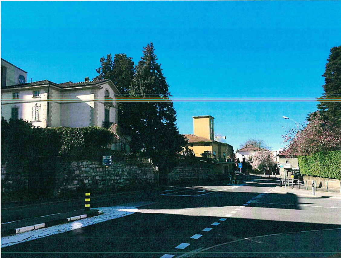
Via Motta – P6 ISOS – con fronte di giardini e recinzioni a muro
