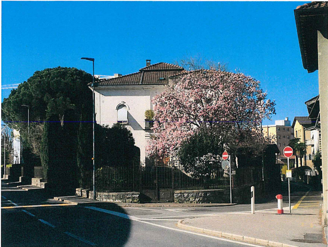
Via Fanchini – Perimetro edificato 6 (P6) ISOS – incrocio con via Diener
