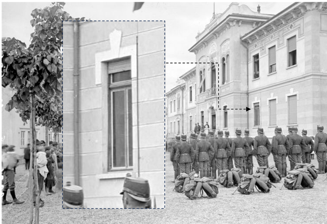
Figura 2: vista del Palazzo comunale e dettaglio della finestra (anno 1914)
