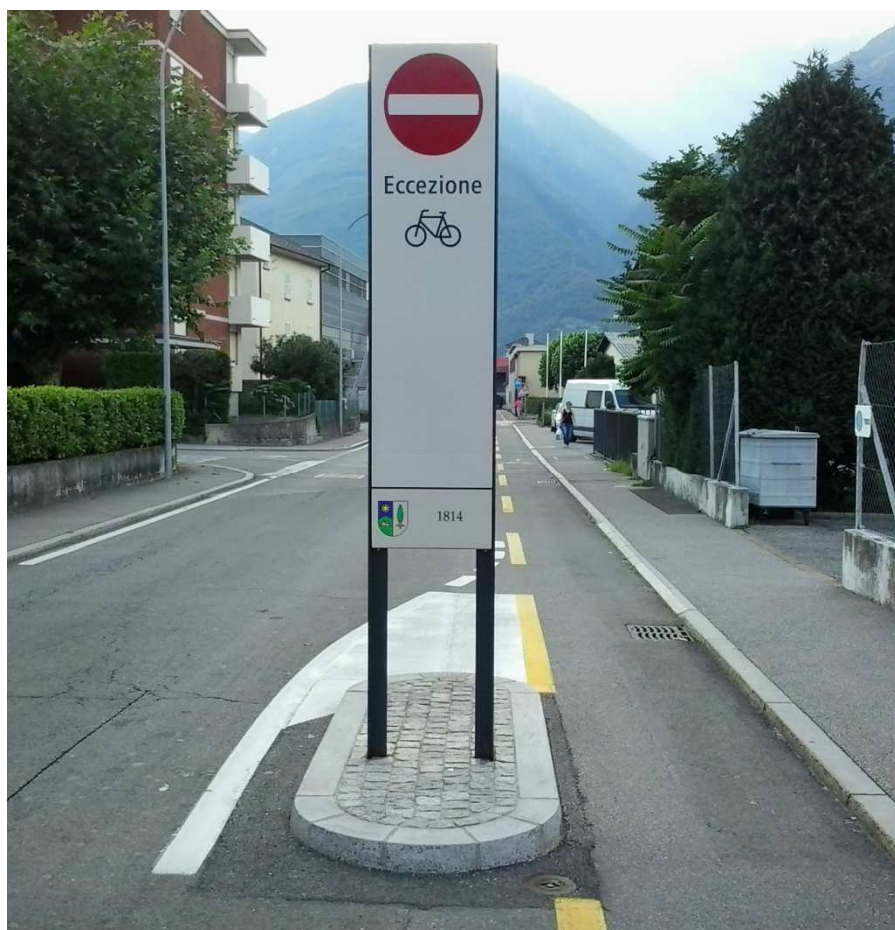
Spartitraffico e demarcazione assicurano la sicurezza delle due ruote nel contro-senso ciclabile a Giubiasco.
