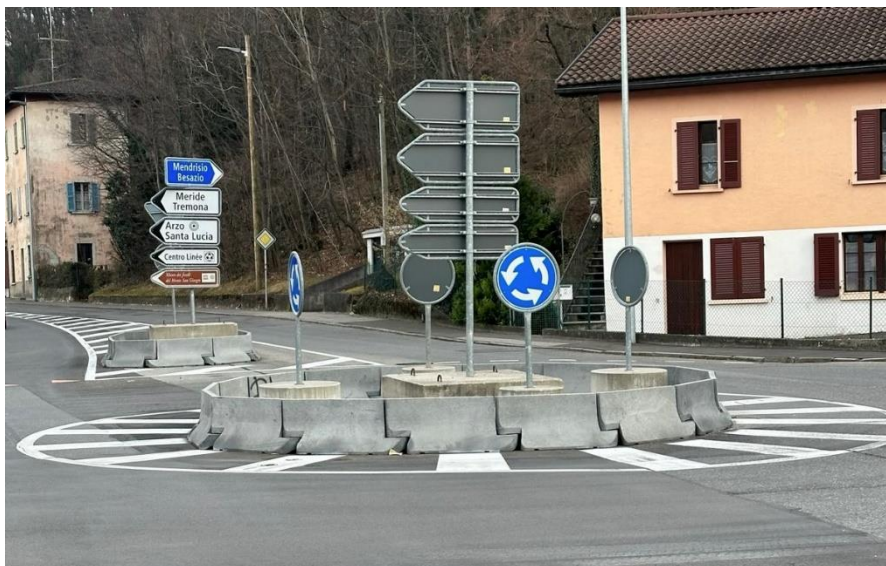
Immagine 1: sistemazione attuale della rotonda
