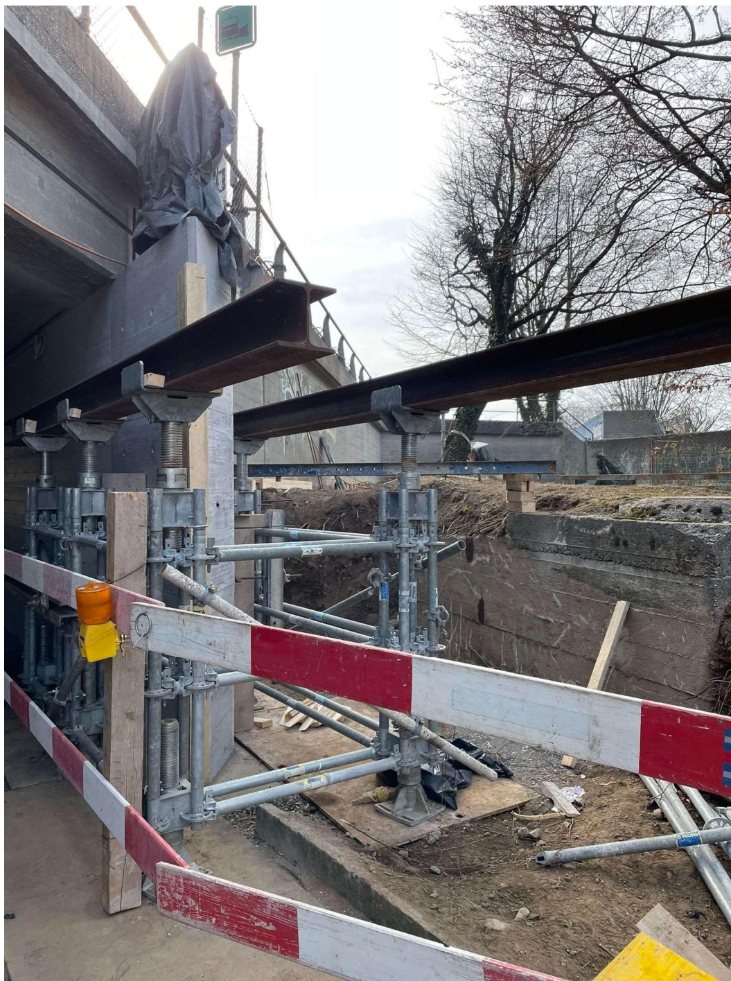
Ponte all'altezza piscine comunali, 21.02.2023
