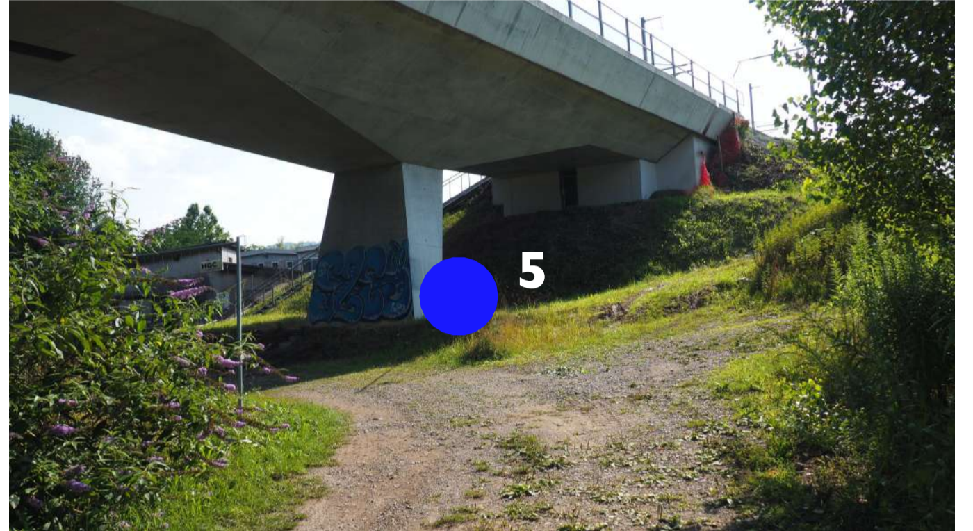
SEDUTA 5, la panchina sfrutta l'ombra dell'esistente ponte delle FFS e il terrapieno che ne ricopre le fondazioni per installarsi in un punto inusuale, ma protetto dal rumore e con uno scorcio sul fiume. L'ampiezza dell'area consente di visualizzare uno spazio di sosta pic-nic.
