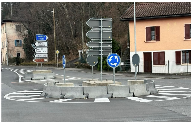
Immagine 1: sistemazione attuale della rotonda
