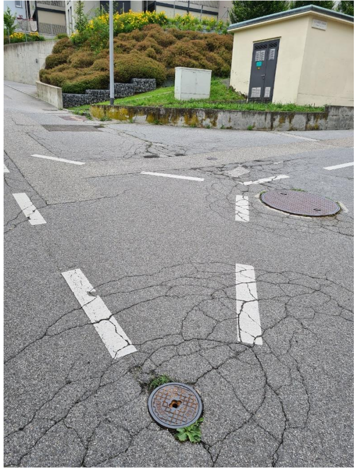
Incrocio Via E. Dunant / Via Guisan
