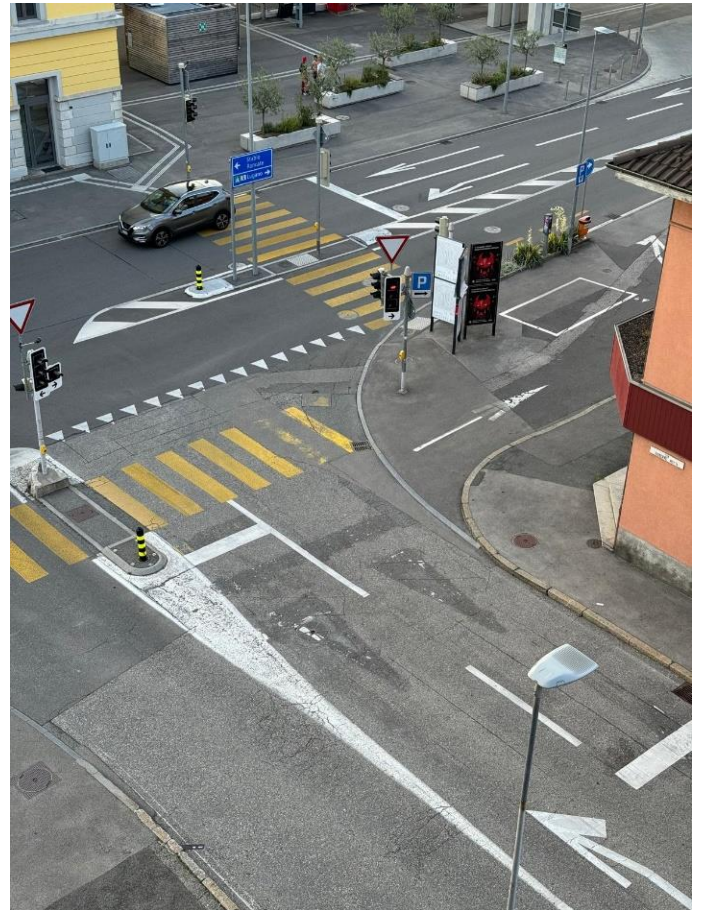
Mendrisio Stazione (con Via Motta, strada comunale)
