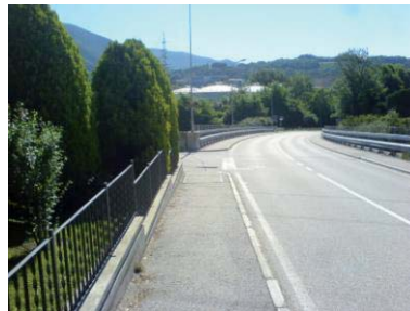
Via della Posta
