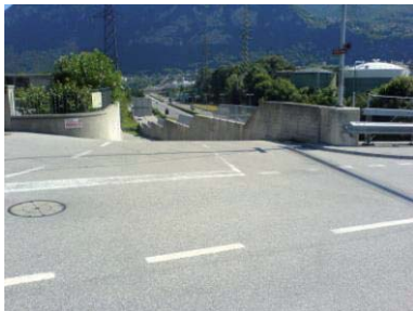
Via della Posta
