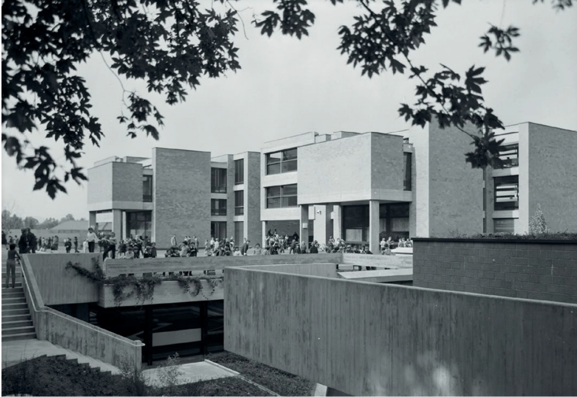
Figura 1: vista dei blocchi A e B, foto Ares Pedrolì (1979)
