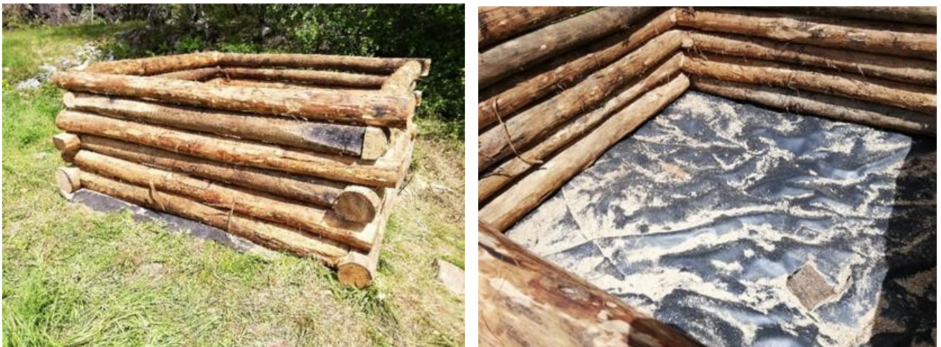
Fig. 10 Esempio di cassoni in legno impermeabilizzati per lo smaltimento della fitomassa proveniente dagli interventi di gestione delle neofite
