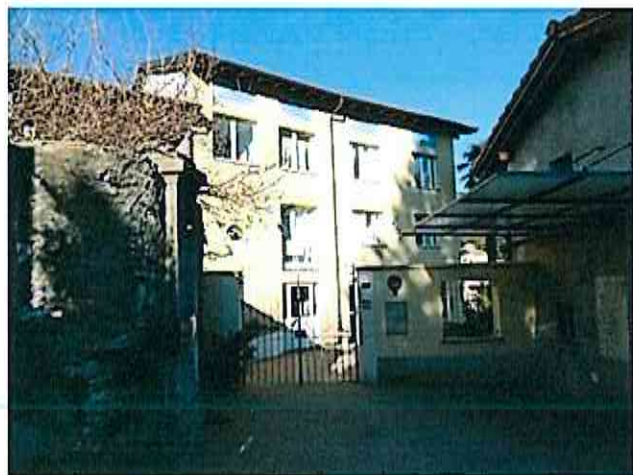
Mappale 57 di recente ristrutturazione
