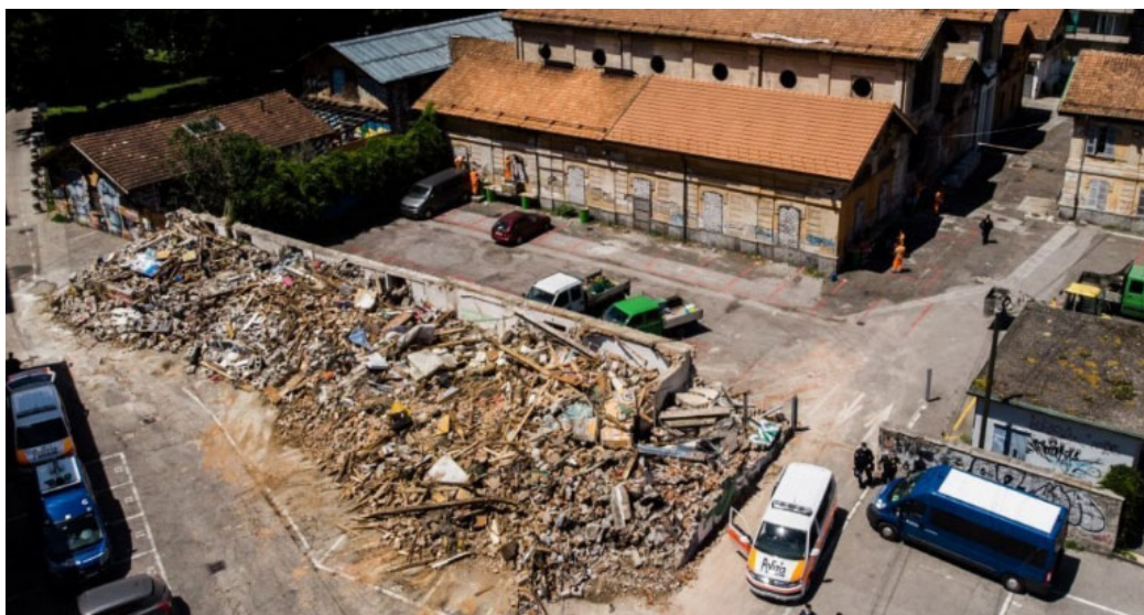
FIGURA 8: DEMOLIZIONE DELL'EDIFICIO POSTO SUL LATO SUD (FONTE LA REGIONE)
