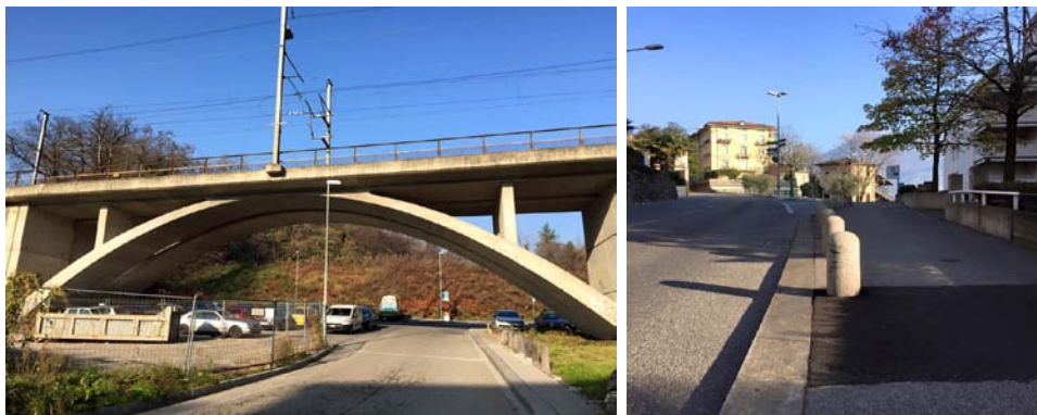
Rivalorizzare ponte ad arco / paracarri e paletti di demarcazione
