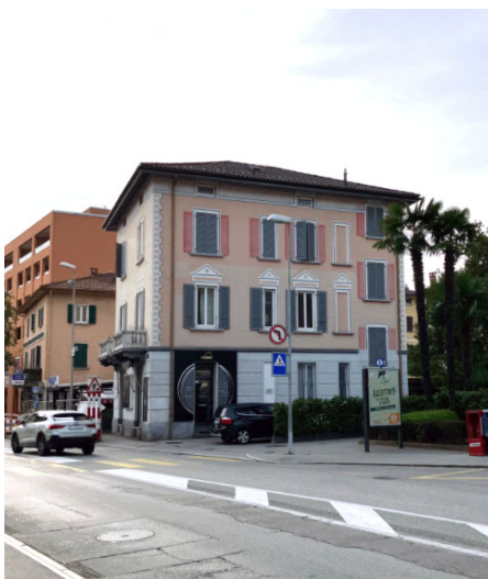
Edificio al mappale no. 14
