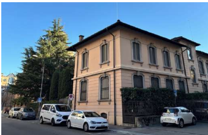
Vista da Ovest, lungo via Buffi (foto STAN)
