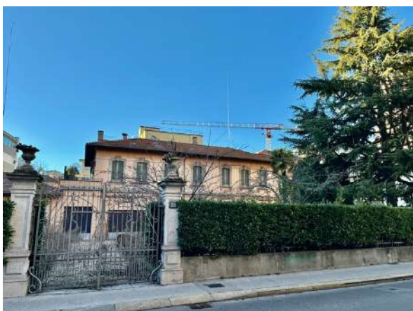
Vista da Est, lungo via Maderno (foto STAN)
