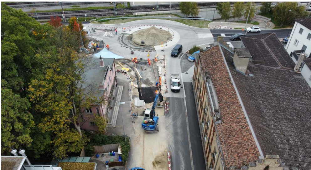
Die Sanierung des Emmishoferkreisels.
