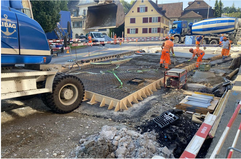
Betonarbeiten Kreisel Sonnenplatz.
