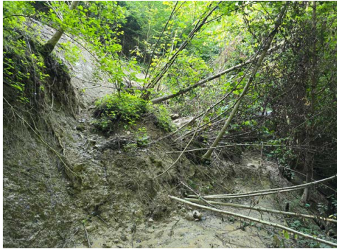
Hangrutsch im Saubachtobel – vorher.
