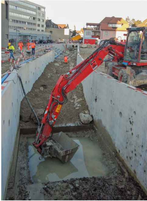
Blick in den neuen Betonkanal im Schoderbach.
