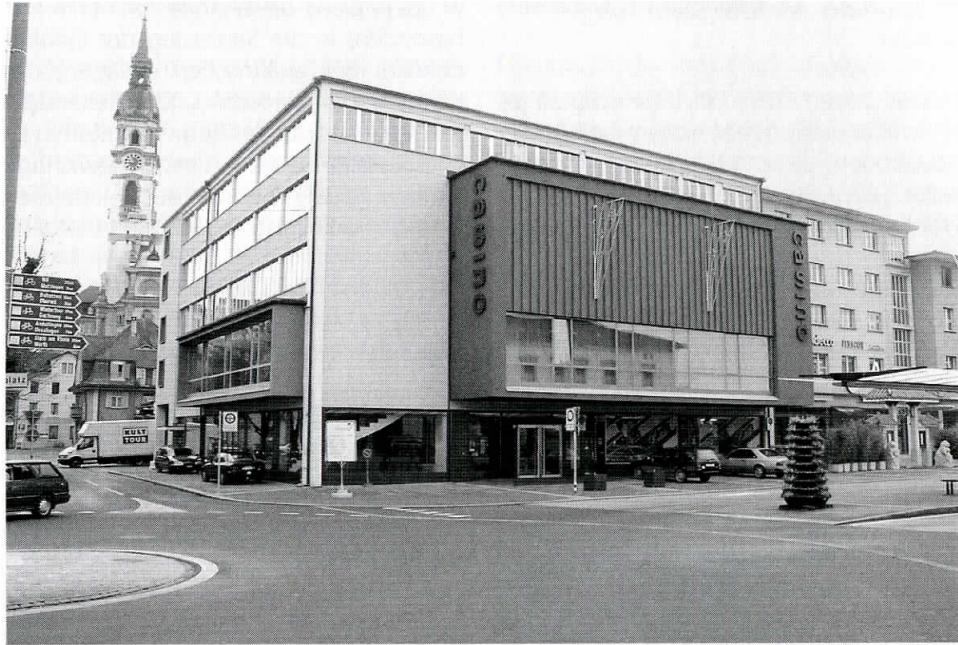
So sieht das Stadtcasino heute aus: Nach den Verputz- und Malerarbeiten im Jahr 2001 erstrahlt die Fassade in neuem Glanz.
