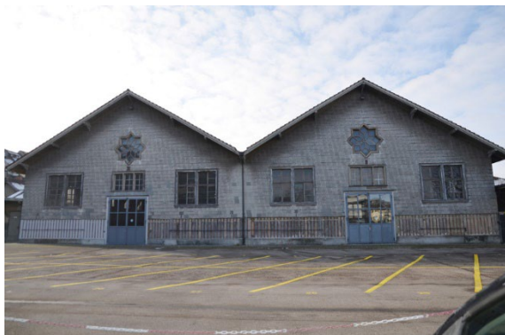
SW- und NO-Fassaden: Gesamtansichten
