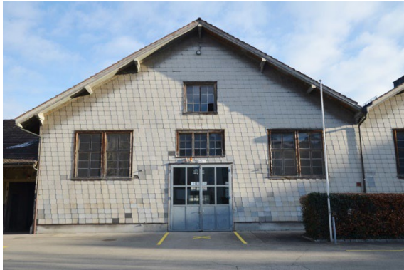
Blick auf SW-Fassade: nördliche Halle
