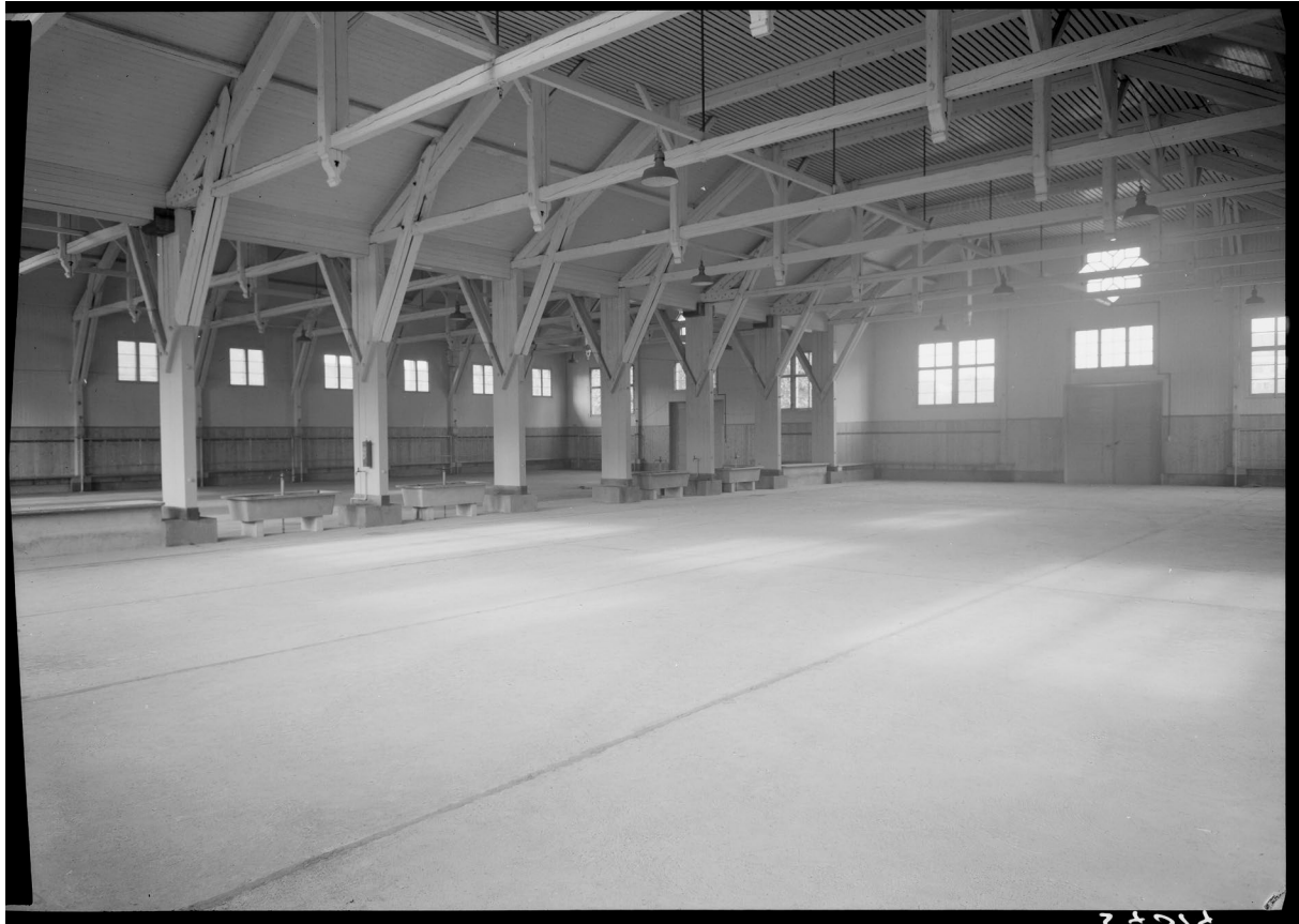
Abb. 29: 1953, Innenraum von Reithalle 3 mit betoniertem Fussboden (Quelle: Stadtarchiv Frauenfeld F 1.2.54014.1 ).
