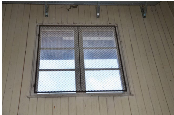
Fest verbautes einfaches Fenster mit Drahtgitterschutz
