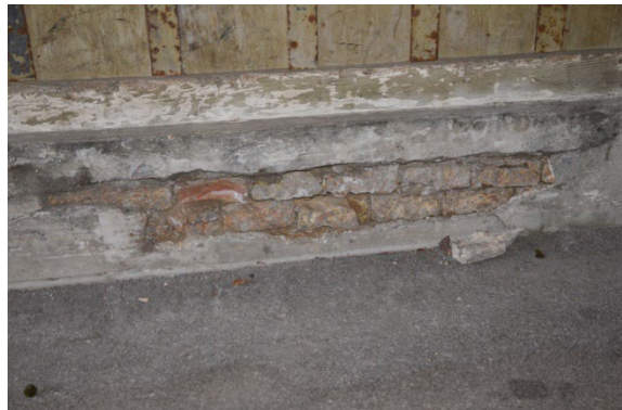
Backsteinsockel mit Verputz
