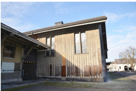
SO-Fassade mit Bretterschirm
