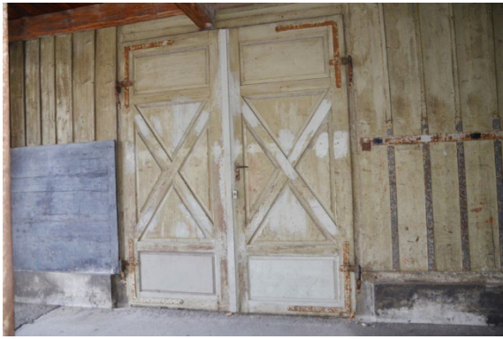
Seitentür zur nördlichen Halle, Aussenansicht
