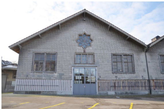
Blick auf NO-Fassade: südliche Halle
