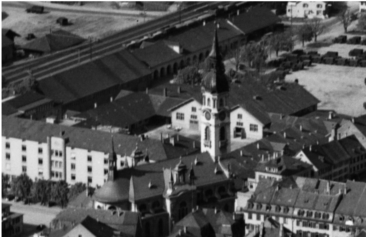
Abb. 30: 1954, Ansicht von Südwesten (Quelle: ETH Bildarchiv, Detail aus LBS_H1-016220).
