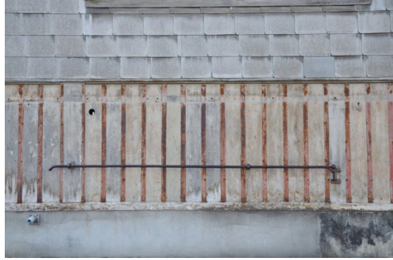
Bleche über den Brettstössen und Haltestange
