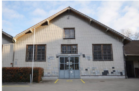
Blick auf SW-Fassade: südliche Halle
