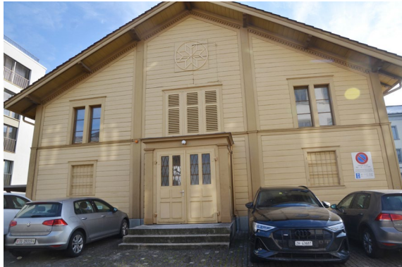
Abb. 3: Giebelfassade der Konvikthalle, Promenadenstr. 14 in Frauenfeld
