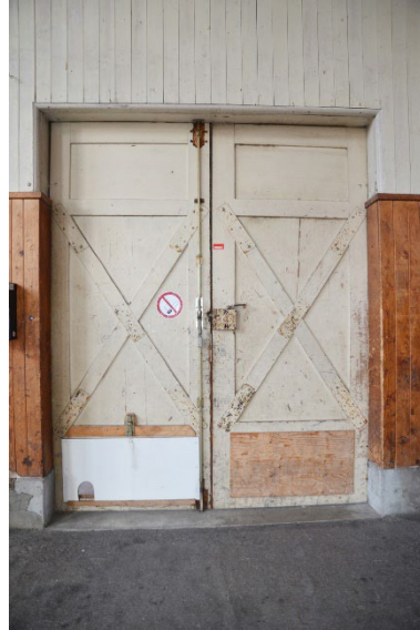
Tür zur Halle, Innenansicht
