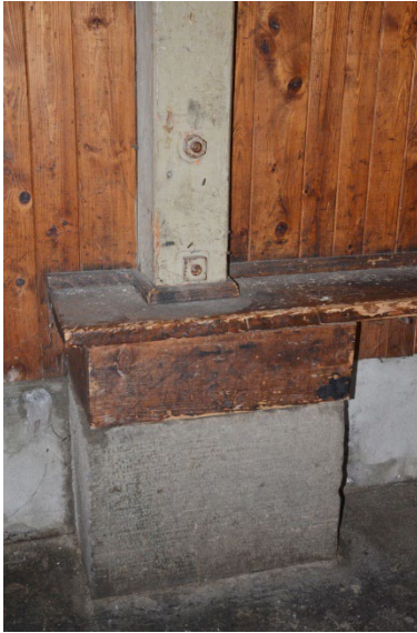
Sockel der Wandstützen aus Naturstein und Holz
