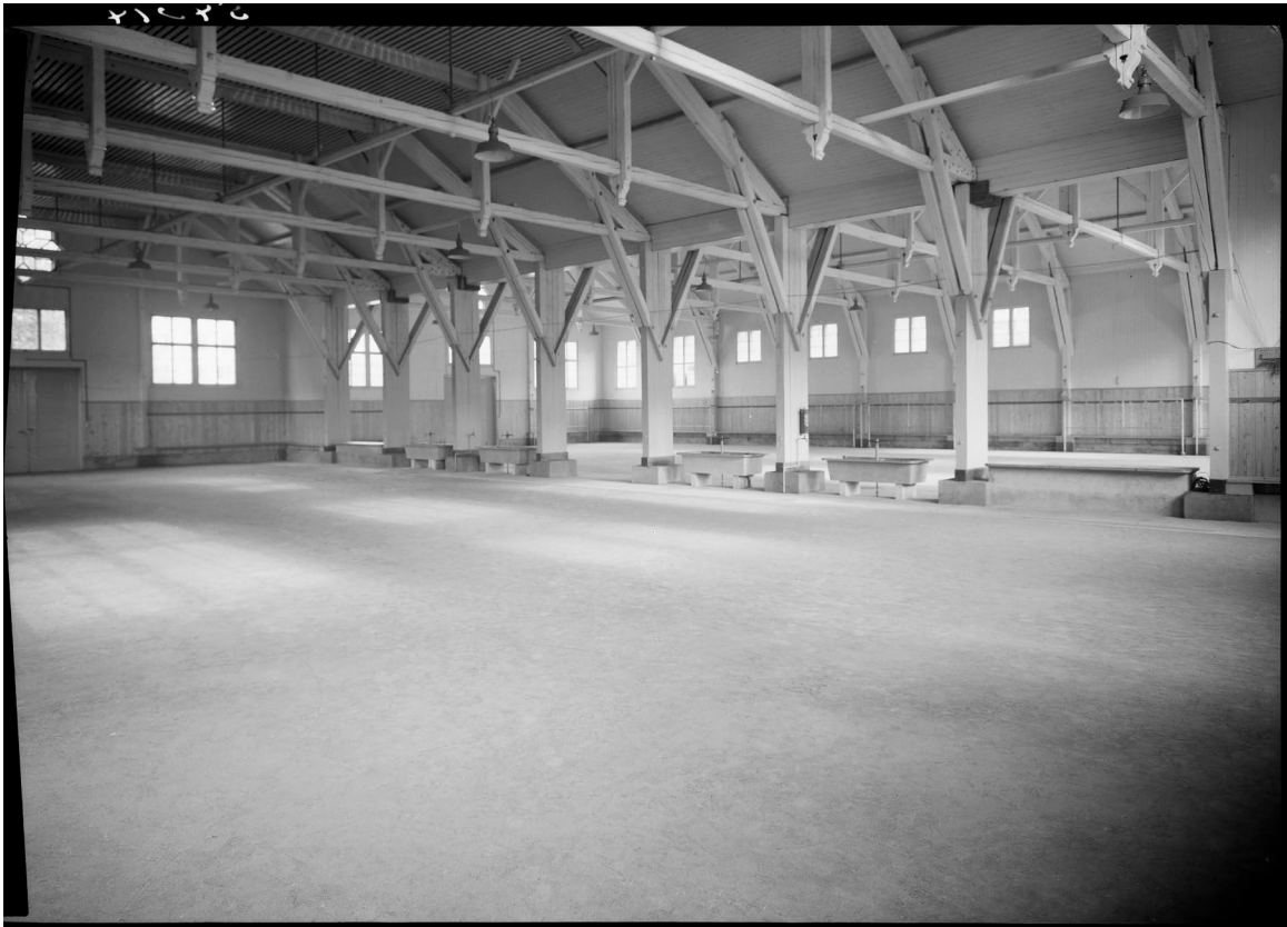
Abb. 28: 1953, Innenraum von Reithalle 2 mit wohl betoniertem Fussboden (Quelle: Stadtarchiv Frauenfeld F 1.2.54014.2).
