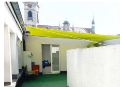
Zugang Innenhof 4. OG nicht IV tauglich
