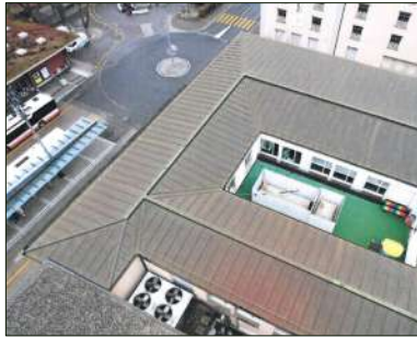
Blechdach in einwandfreiem Zustand
