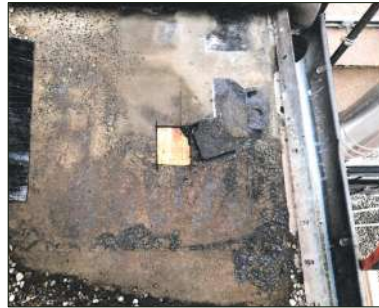
Kiesklebedach in optisch gutem Zustand
