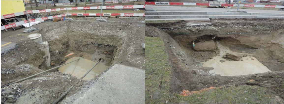
Murg-Unterquerung mittels gesteuerter Erdbohrung
