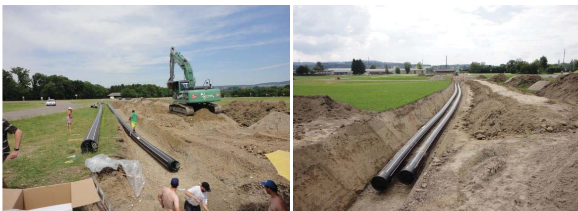
Bau der Wärmeübertragungsleitung von der ARA Richtung Stadtzentrum
