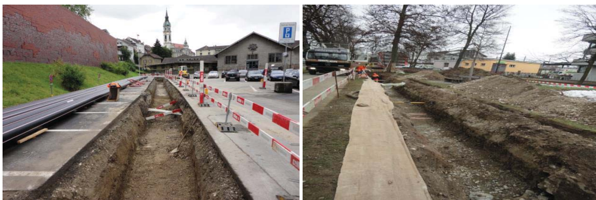
Leitungsbau im Bereich des Staatsarchivs und des Lindenparks
