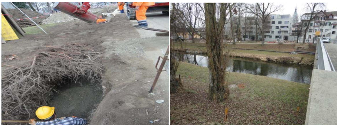
Vorbereitungsarbeiten zur Unterquerung der Murg im Bereich des Lindenparks
