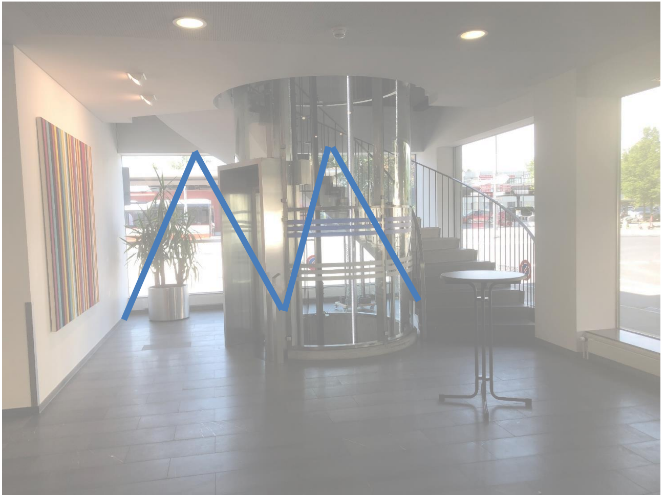
ABBILDUNG 15: NEUES FACHWERK ZUR ERDBEBENAUSSTEIFUNG
