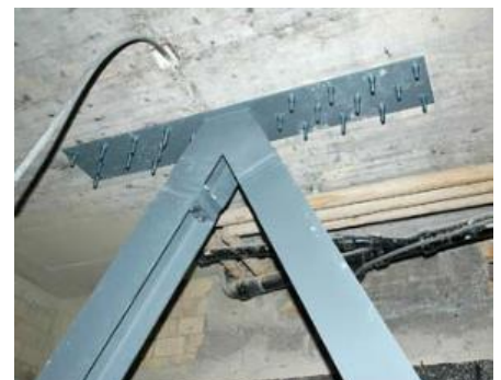
ABBILDUNG 14: FACHWERKAUSSTEIFUNG
