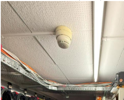
Bild 17 Trasse in Bühnentechnik (überfüllt)
