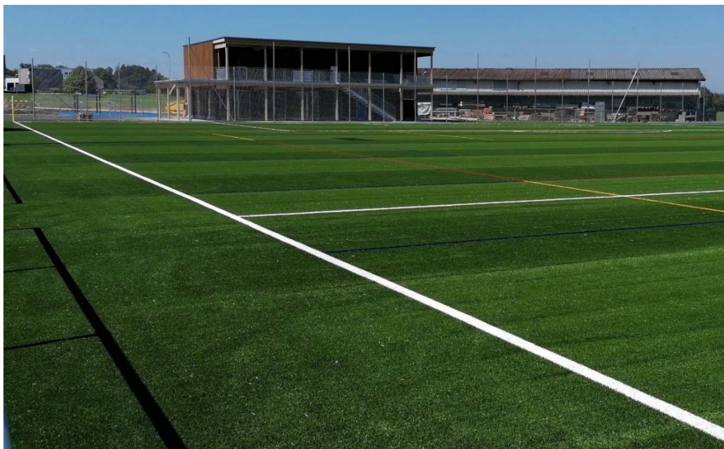
Abbildung 6: Kunstrasen unverfüllt ohne Granulatverfüllung, Quelle: bhateam ingenieure ag, Fussballplatz Waldkirch 2022
