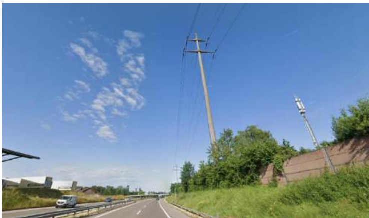
Abbildung 4: Foto SBB-Starkstromleitungen, Streetview map.google.com
