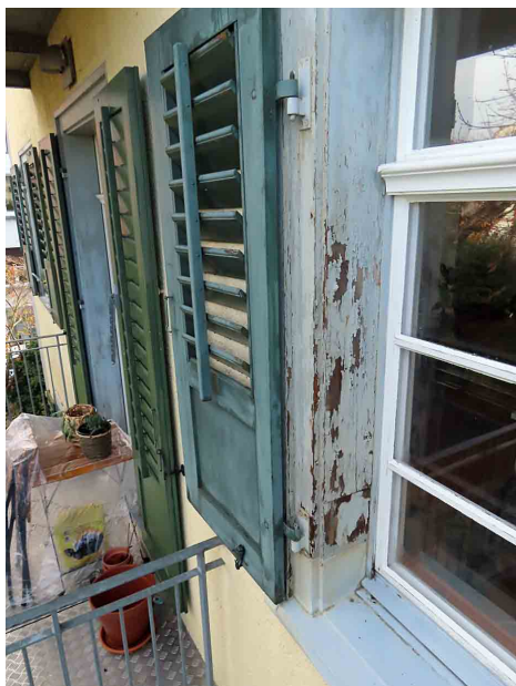
Auf dem Holzwerk (siehe Abbildungen links und oben) liegen zum Teil grossflächige Anstrichabplatzungen vor. Dies betrifft vermehrt die West- und Nordfassade von Haus gelb.
