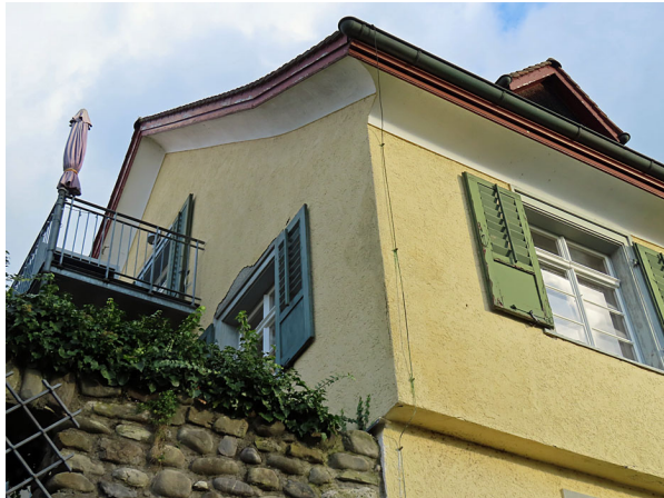
Die Nordfassade von Haus gelb war nur auf einem Teilbereich zugänglich, im oberen Bereich liegt im Untergrund vermutlich auch ein Schindelschirm vor.
