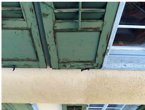
Auf dem Holzwerk (siehe Abbildungen links und oben) liegen zum Teil grossflächige Anstrichabplatzungen vor. Dies betrifft vermehrt die West- und Nordfassade von Haus gelb.
