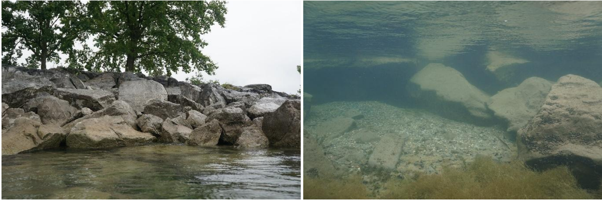
Abb. 13: Mit groben Blockwurf verbautes Ufer. Die Wellenschlagzone ist so gut wie nicht bewachsen.
