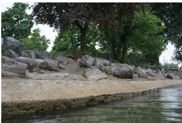
Abb. 2: Uferbau mit Beton und Blöcken, teilweise unterspült bei Transekt A.
