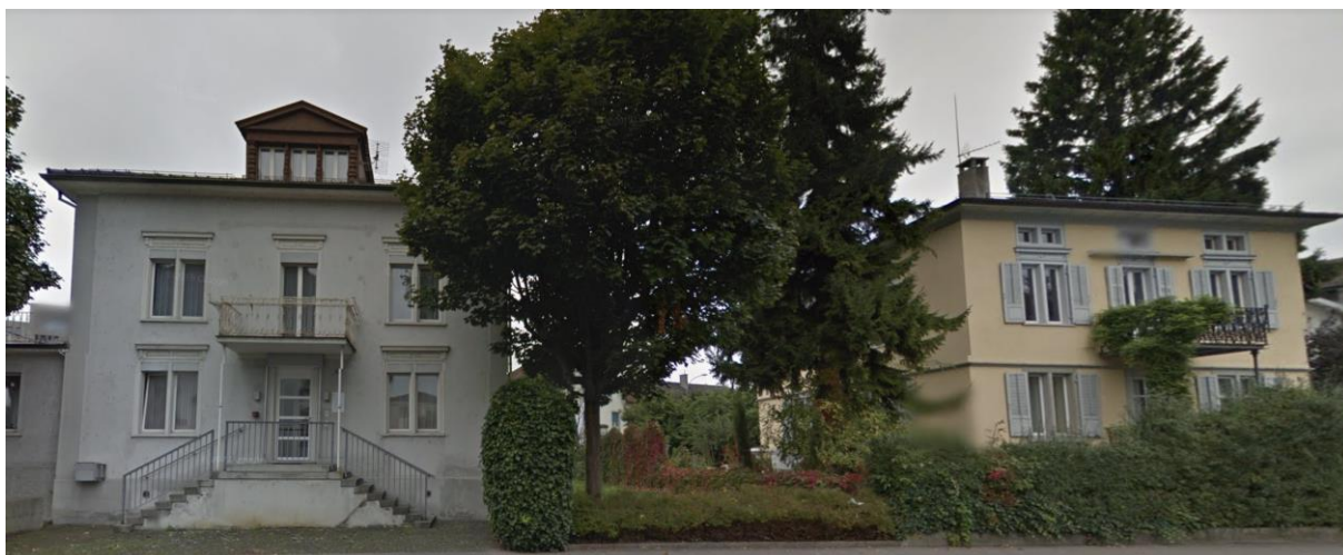
Abb. 1, links die Liegenschaft der Stadt (Bahnhofstr. 24), rechts die privat gehaltene Liegenschaft (Bahnhofstr. 22)
