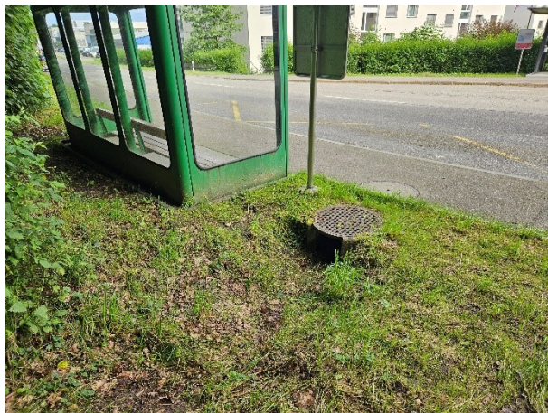
Abbildungen 6: Das bestehende Einlaufbauwerk des Müllitalwandbachs.
