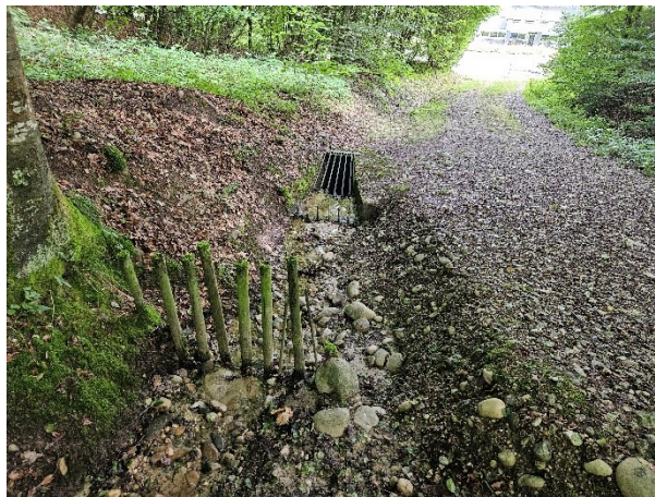
Abbildungen 11: Das bestehende Einlaufbauwerk des Schafhubelbachs.
