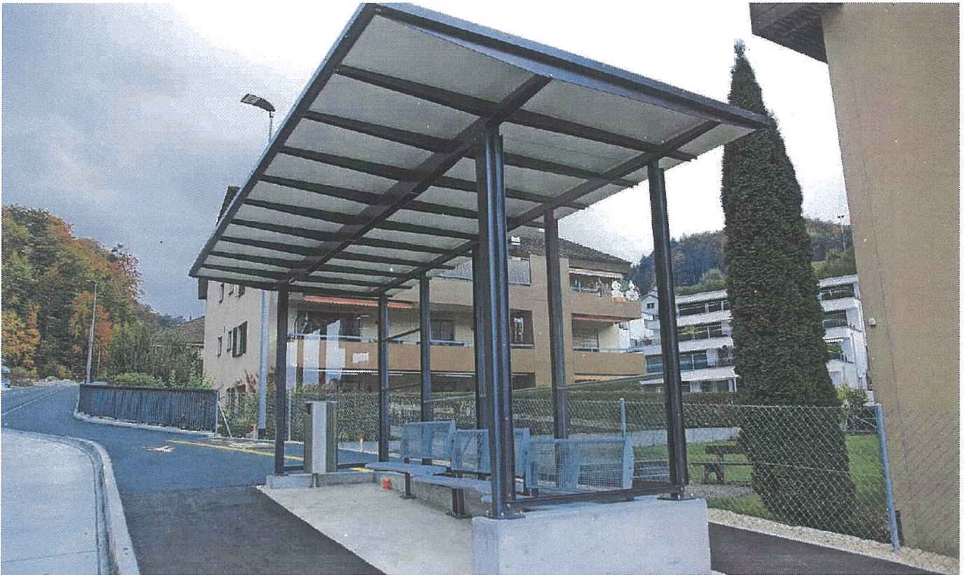
Zofingens Verantwortliche sind überzeugt, dass der nunmehr gewählte Typ des Buswartehäuschens sicher, dauerhaft und gebrauchstauglich ist. Das Bild zeigt das Buswartehäuschen Weiher.
