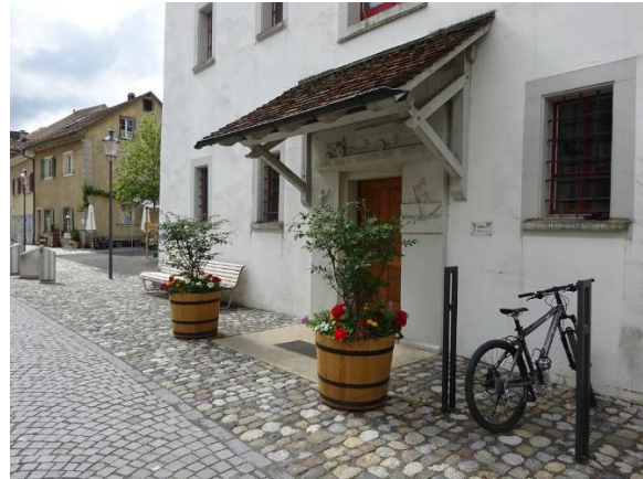
Bild 2: Wackepflasterung im Seitenbereich
