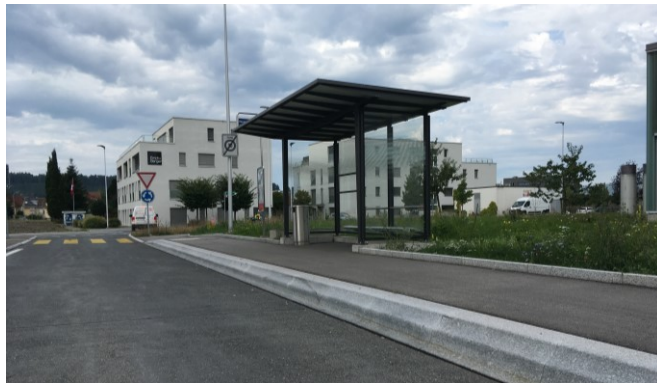
Beispiel barrierefreie Haltekante inkl. Wartehäuschen an der Henzmannstrasse
