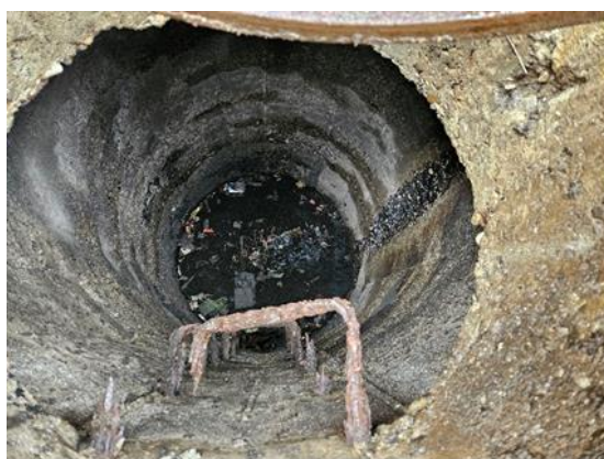
Abbildung 2: Versickerungsschacht bei der Unterführung Brühlgässli
