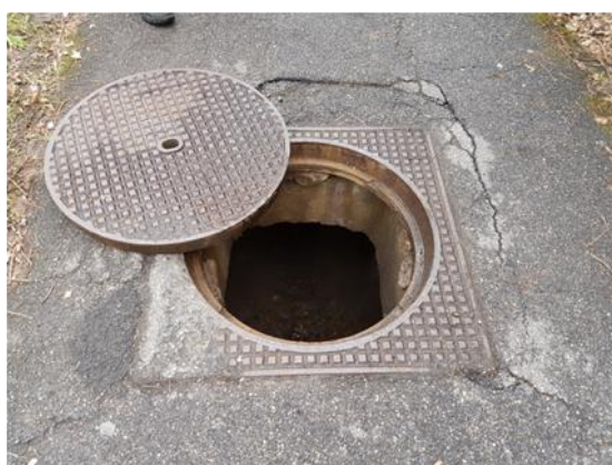
Abbildung 3: bestehende Bachleitung im Brühlweg mit geringer Überdeckung
