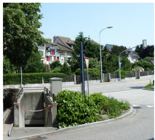
Standort MWRA Parkhaus, Fluchttreppe/Notausstieg
