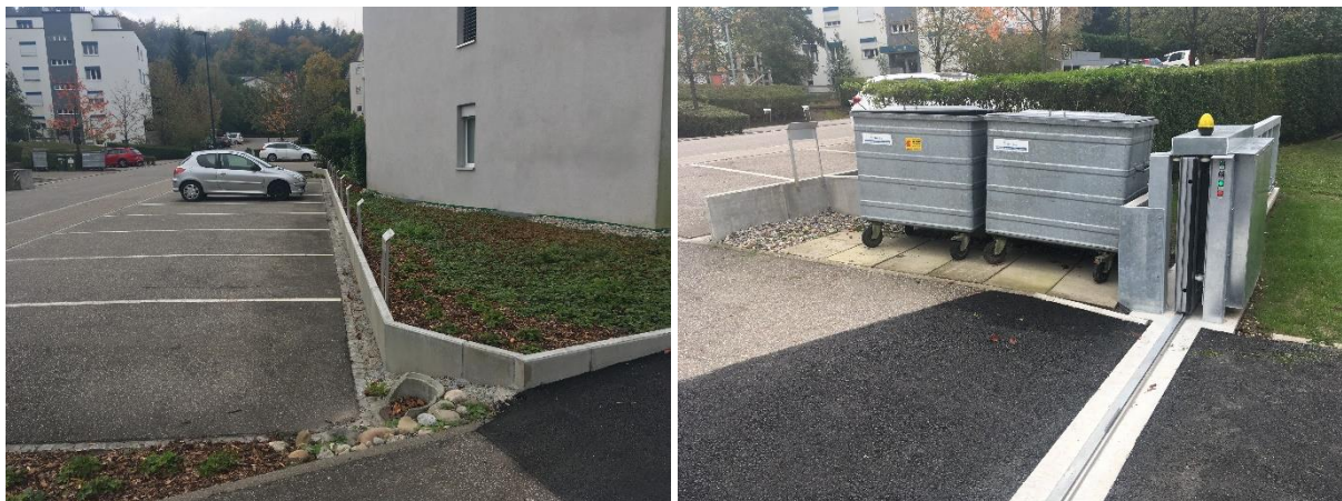
Abbildung 22: Umgesetzte Objektschutzmassnahmen entlang der Hottigergasse.
