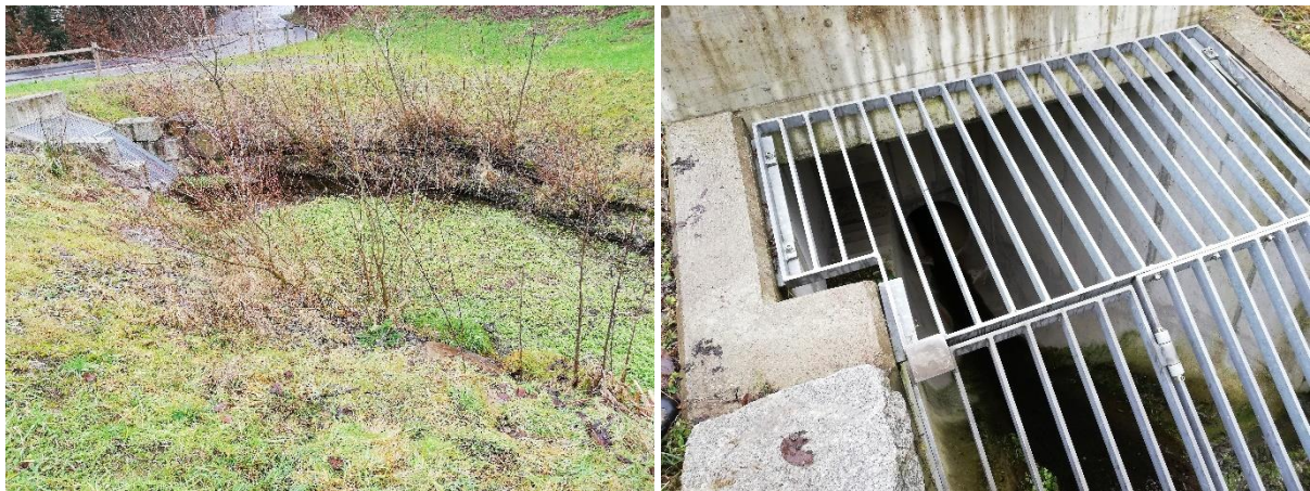
Abbildung 17: Beispiel Einlaufbauwerk mit vorgelagertem Absetzraum.
