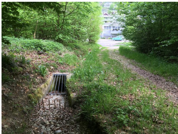
Abbildung 25: Bestehender Einlauf «Schafhubel».
