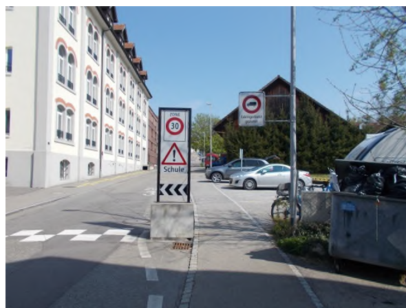
b) Pilatusstrasse mit Durchfahrtswiderstand und signalisierter Tempo-30-Zone
