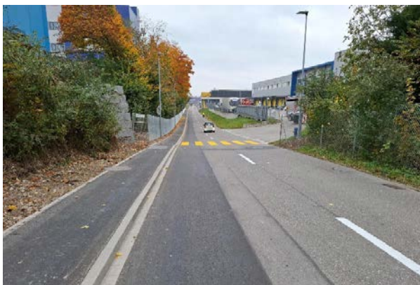
Neuer Gehweg und Fussgängerstreifen an der Industriestrasse
