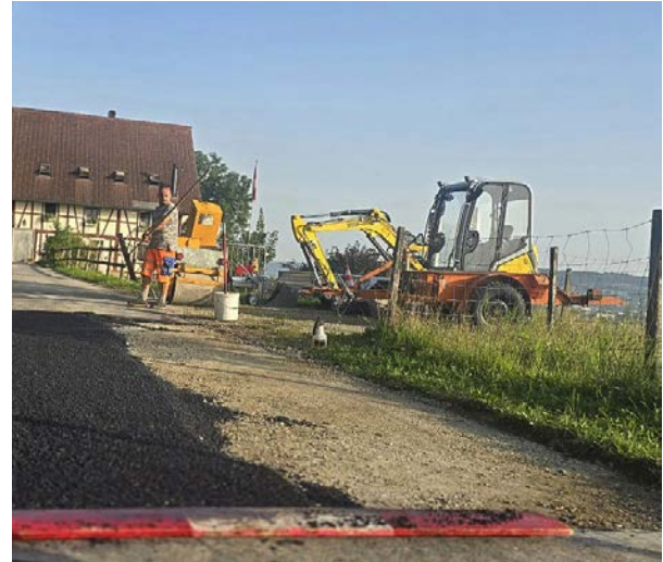
Belagssanierung mit Randverstärkung im Gebiet Harzer Hof
