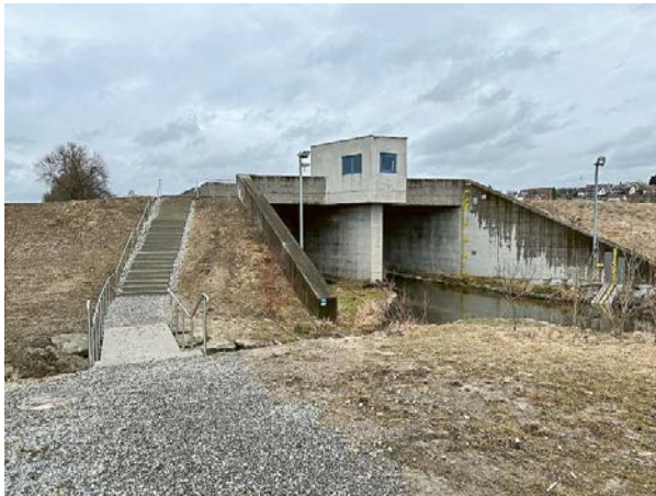
Neuer Übergang über den Büelisacherkanal
