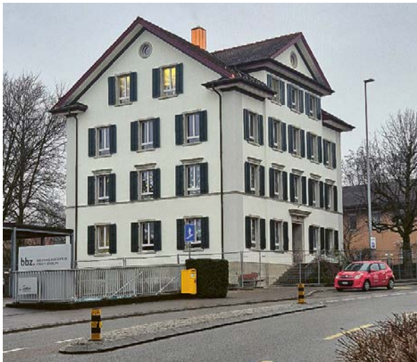
Saniertes Haus Wietlisbach
