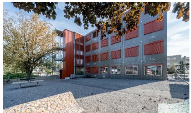
Containermodule Oberdorfweg zur Wiederverwendung
