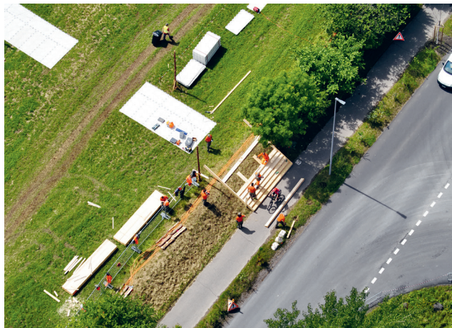
Jublasurium: Aufbau einer Treppe
