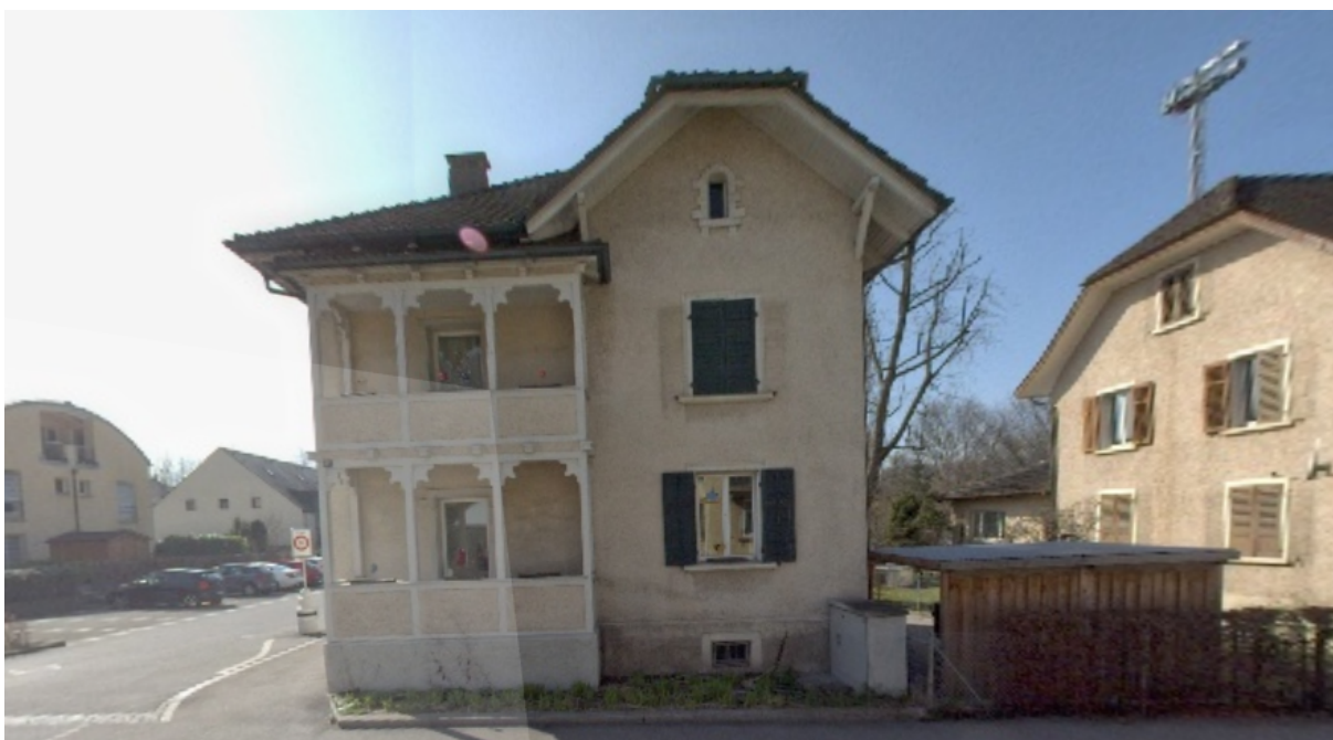
Zustand Altliegenschaft Schartenstrasse 42 aussen
