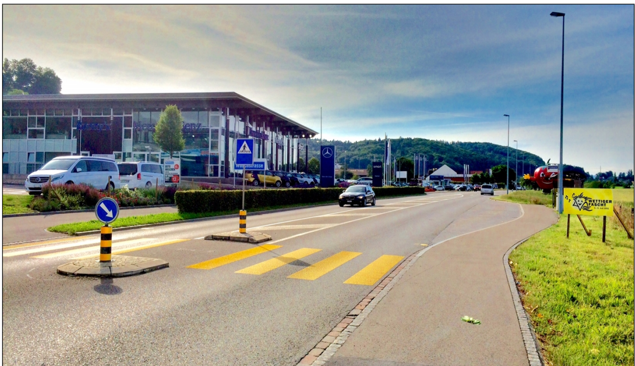
SG: 9 Projekterweiterung "Kreuzkapelle": Belagsanierung, Fussgängerschutzinsel und Bushaltestelle
