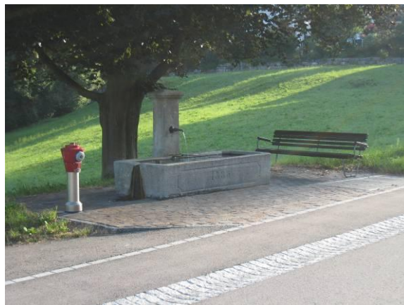
Sanierter Verweilplatz mit Brunnen und Sitzbank
