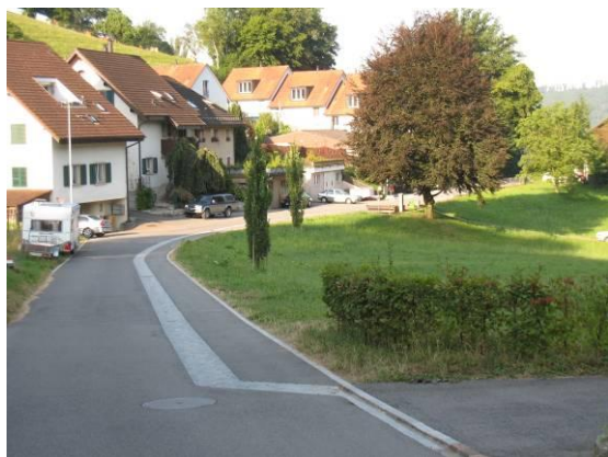
Sanierte Aeschstrasse mit wasserführender Rinne und Baum- und Heckenpflanzung
